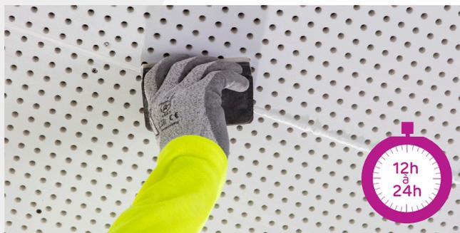
**8** Après séchage complet du produit (12 à 24 h), effectuer le ponçage des joints.
