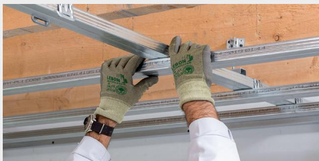
**1** Positionner les suspentes suivant les entraxes indiqués, puis fixer les profilés porteurs principaux CD60. Positionner les cavaliers tous les 40 cm pour les profilés de support de plaques CD60.
