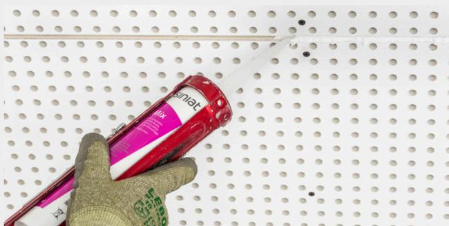
**7** S'assurant que les joints soient entièrement remplis. Laisser déborder l'enduit du côté apparent de la plaque.
