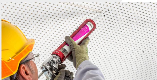
**6** À l'aide d'un pistolet manuel (ou électrique), appliquer l'enduit cartouche SINIAT MIX. Recouvrir les têtes de vis avec l'enduit cartouche SINIAT MIX.
