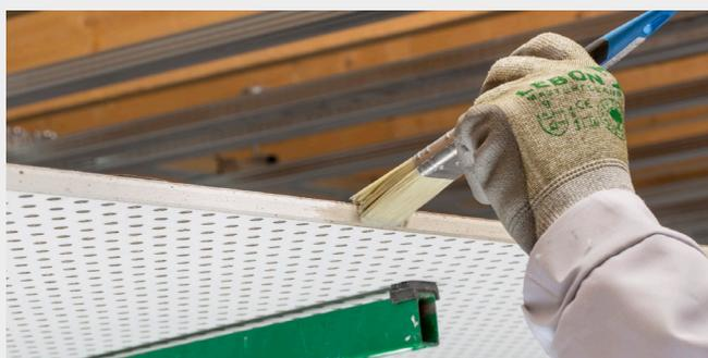
**5** Il est nécessaire d'appliquer au préalable le primaire d'accrochage sur les bords coupés sur chantier.
