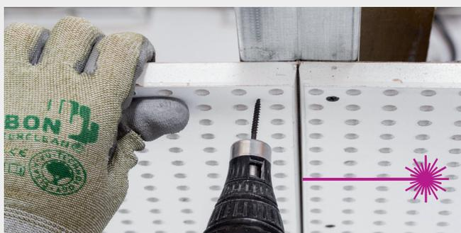
**3** Positionner les plaques bord à bord en vérifiant le bon alignement des plaques et la continuité des perforations, de préférence à l'aide d'un laser.
