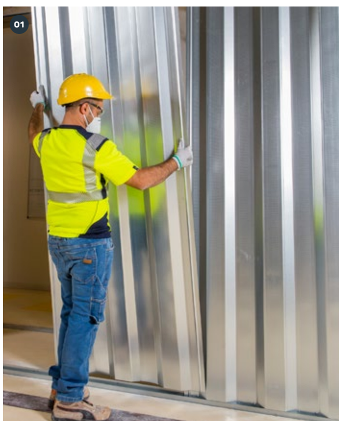
POSE DES BACS SecurBlock
