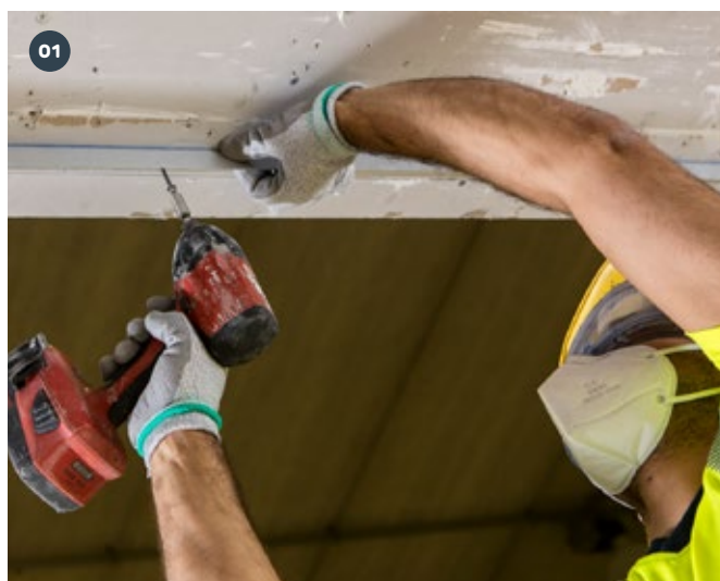
POSE DE LA CORNIÈRE 24-32 EN PARTIE HAUTE
