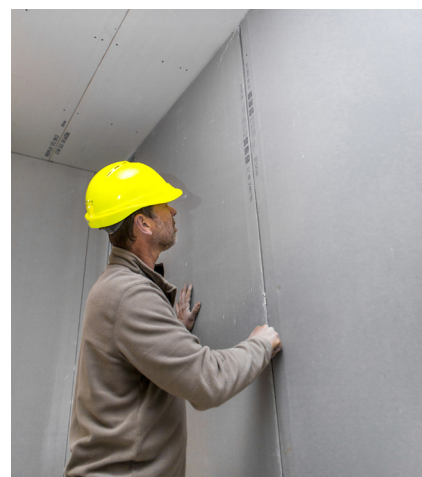
Mise en œuvre de SOLIDROC®, la plaque de plâtre très haute résistance à l'accrochage, aux chocs, à l'humidité et aux bruits.
