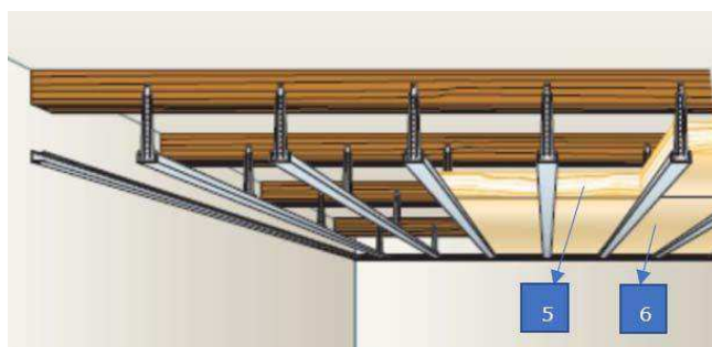
Figure 4 - Mise en place de l'isolant
