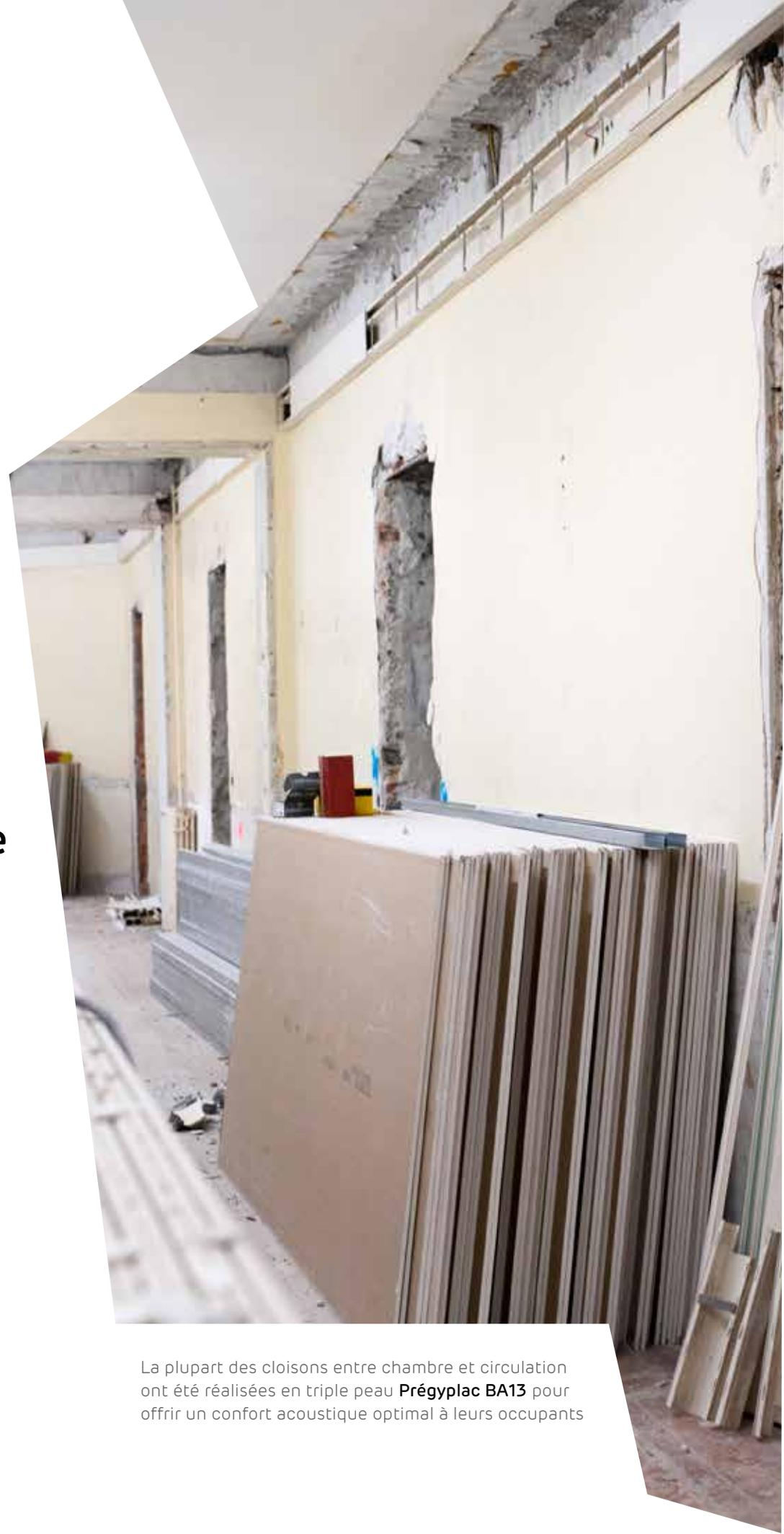
La plupart des cloisons entre chambre et circulation ont été réalisées en triple peau **Prégyplac BA13** pour offrir un confort acoustique optimal à leurs occupants
