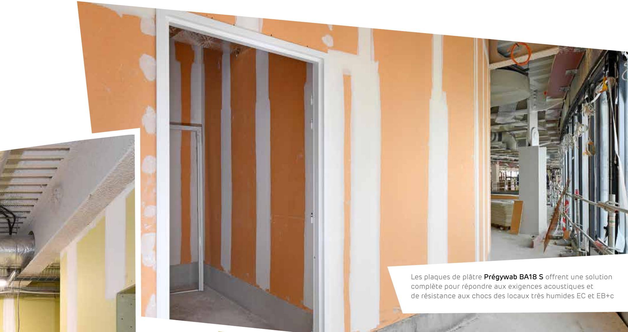
Les plaques de plâtre **Prégywab BA18 S** offrent une solution complète pour répondre aux exigences acoustiques et de résistance aux chocs des locaux très humides EC et EB+c
