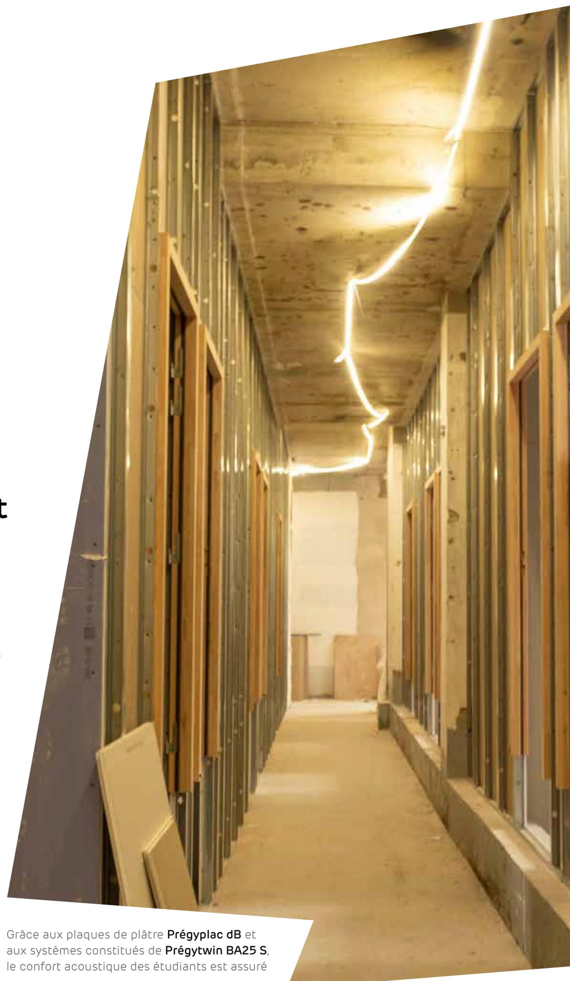
Grâce aux plaques de plâtre **Prégyplac dB** et aux systèmes constitués de **Prégytwin BA25 S**, le confort acoustique des étudiants est assuré
