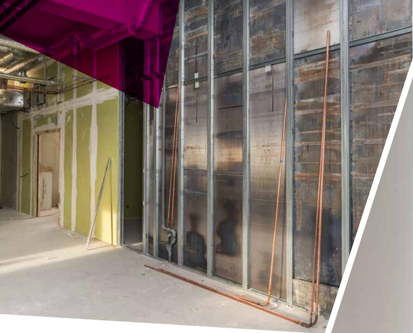
Les cloisons constituées d'une feuille de plomb permettent de réaliser des salles de radiologie, compatibles avec la plupart des rayons X
