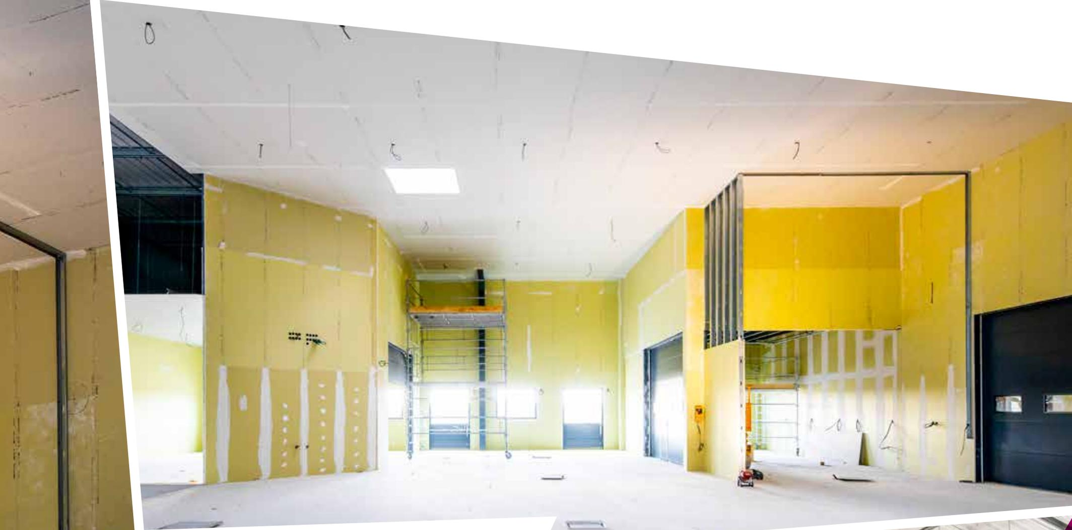
Les cloisons **Prégymétal Industrie** avec parement simple **Prégyplac BA18 S** et montants **Prégymétal M125** offrent de hautes performances mécaniques jusqu'à 12 m de hauteur
