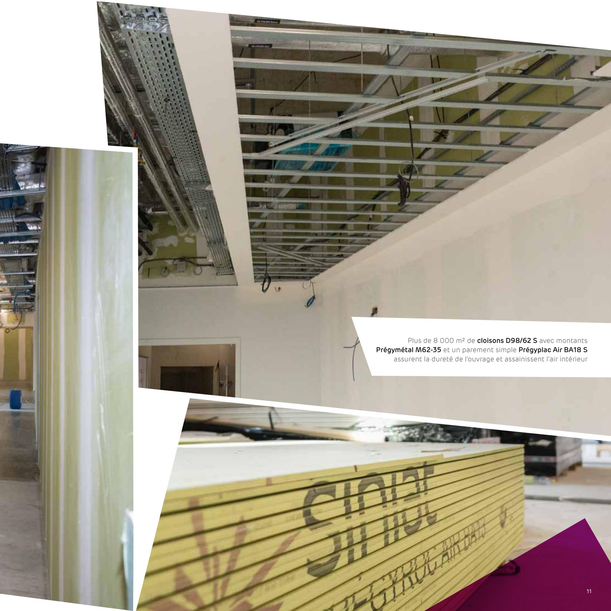
Plus de 8 000 m<sup>2</sup> de cloisons D98/62 S avec montants Prégymétal M62-35 et un parement simple Prégyploc Air BA18 S assurent la dureté de l'ouvrage et assainissent l'air intérieur
