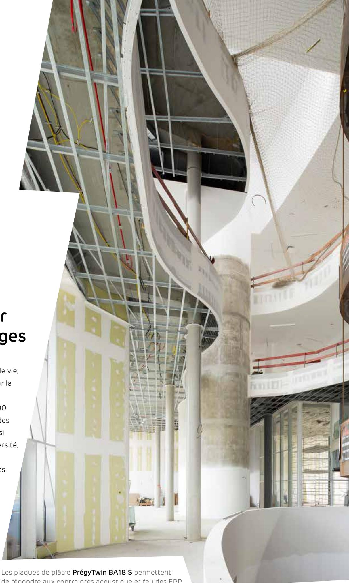
Les plaques de plâtre **PrégyTwin BA18 S** permettent de répondre aux contraintes acoustique et feu des ERP
