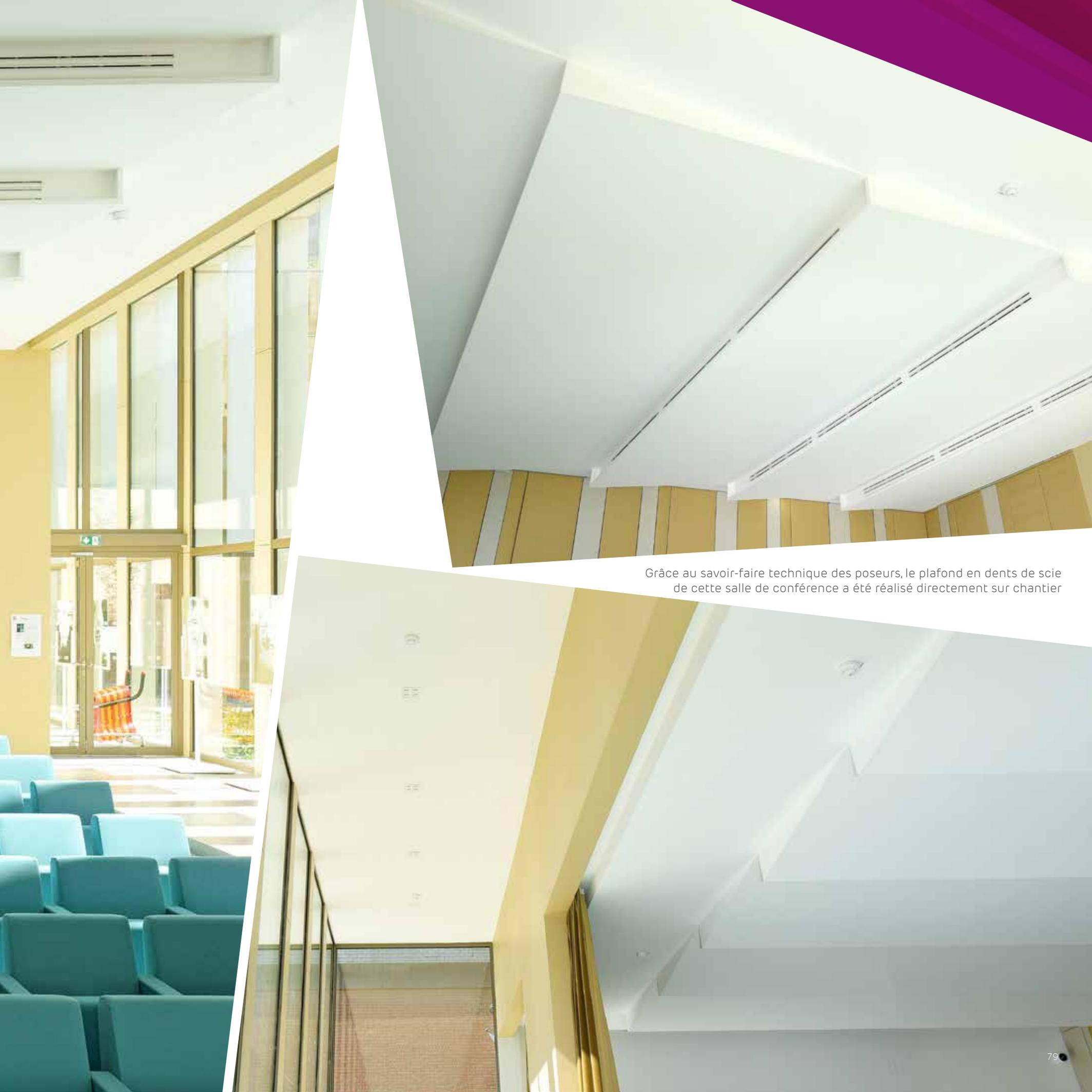
Grâce au savoir-faire technique des poseurs, le plafond en dents de scie de cette salle de conférence a été réalisé directement sur chantier
