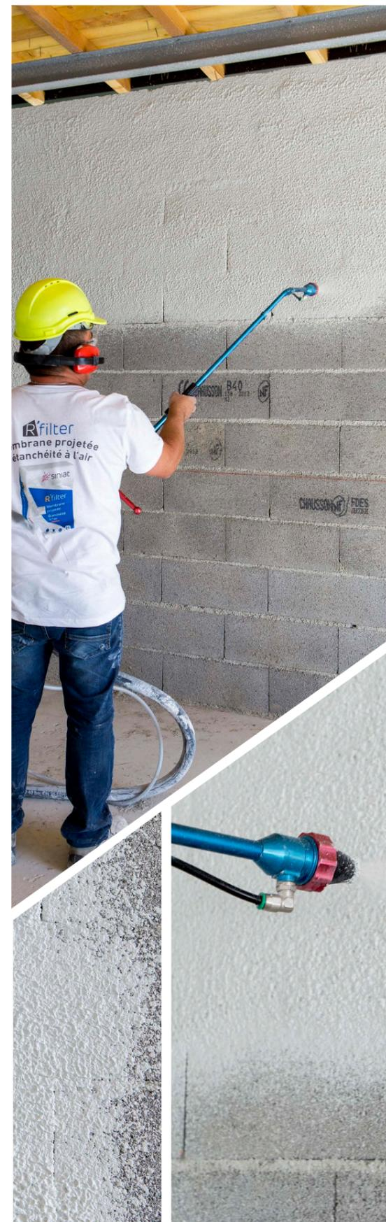
La membrane **R'Filter** se projette rapidement et facilement sur le mur maçonné (parois verticales froides ou donnant sur un local non chauffé) avant pose des plafonds ou plafonds faits.
