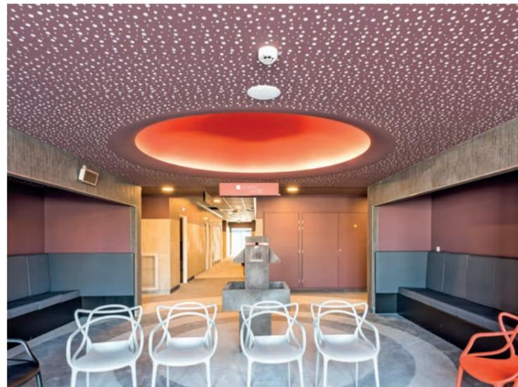
Tisanerie avec coupole Siniat Design® et plafond en plaques de plâtre perforées acoustiques Createx.
